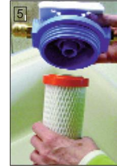
5. Nun setzen Sie den neuen Filtereinsatz mit der Öffnung auf den Filtergehäusedeckel fest ein. Einfach vorsichtig hineindrücken. Dann setzen Sie den Filtergehäusedeckel mit dem Filtereinsatz auf das Filtergehäuse. Achten Sie darauf, dass die runde Gummichtung in der Rille liegt. Dann drehen Sie mit dem Gehäuseschlüssel den blauen Gehäuse-Feststellring rechtsdrehend das Gehäuse wieder zusammen. Nicht mit Gewalt anziehen!
